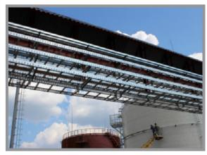
**ОКЛ-2**, **ОКЛ-3** Прокладка кабеля в металлических лотках серии УЛ(H), УЛ(П) и лотках-коробах серии ЛПМЗТ(М), ЛНМЗТ(М)
