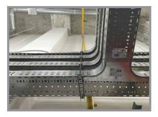
**ОКЛ-4** Прокладка кабеля в металлических проволочных лотках серии ПЛМ, ПЛМ(н)
